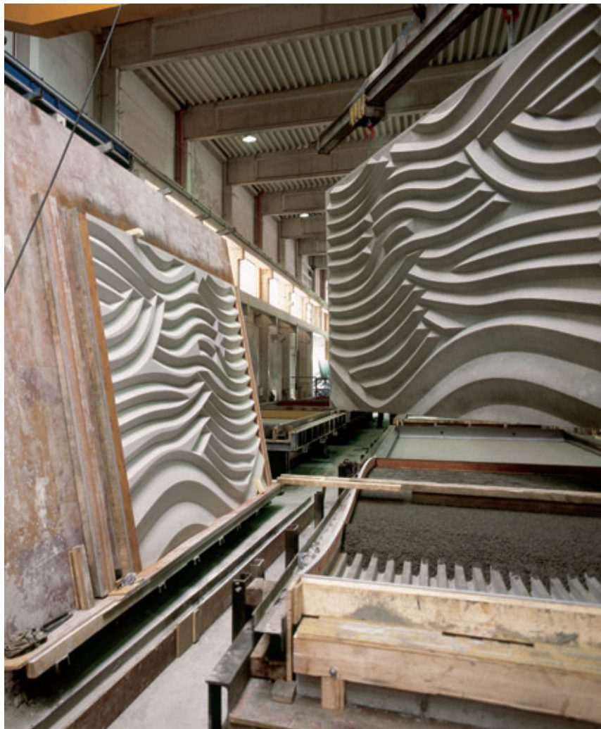
Strukturmatrizen als Schalung
