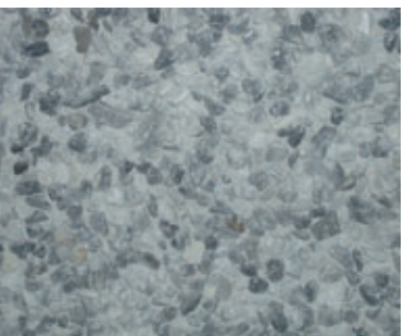
Abgetragene Oberfläche mit Hardeberga-Granit
