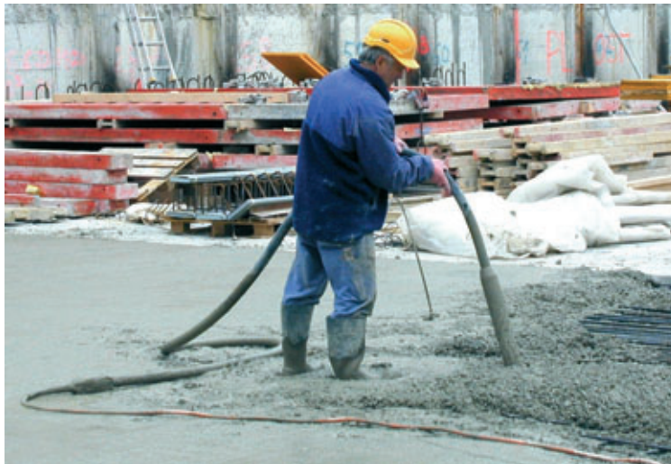
Verwendung eines Innenrüttlers
