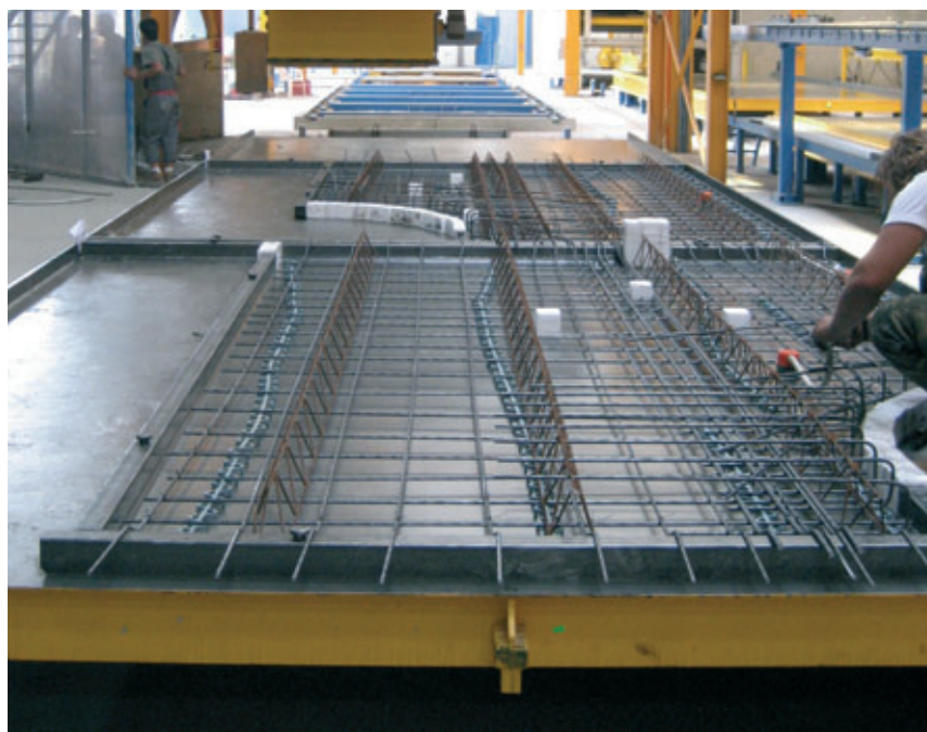
Stahlschalung bei der Betonfertigteilproduktion
