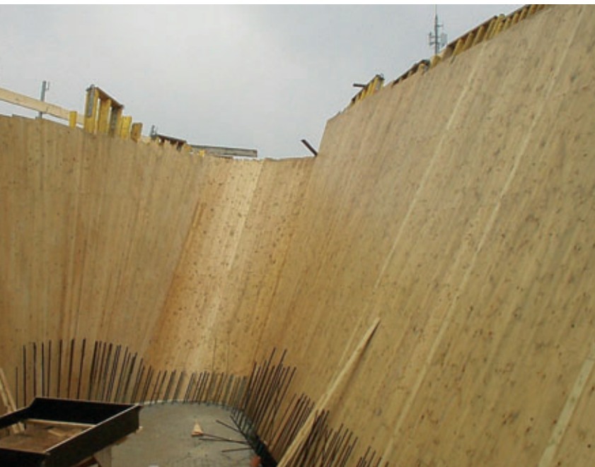
Holzschalungen beim Bau des phæno science center in Wolfsburg von Zaha Hadid
